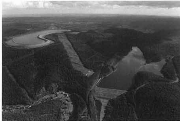
FIGURE 14 – Photo des réservoirs de la S.T.E.P. de Revin
